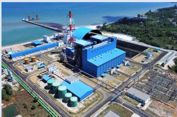
位于印度西加里曼丹省西北部 Bengkayang 市的巴比巴卢燃煤电站项目，是公司在海外实施的首个火电 EPC 项目，装机规模为两台 55MW 燃煤发电机组。项目是印尼第二期 1,000 万千瓦电力发展计划重点项目，建成后将极大缓解西加里曼丹岛的电力供应紧张局面。
